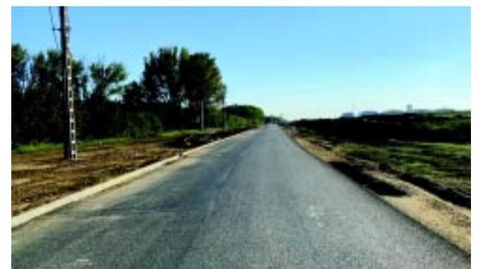
Új elektromos hálózat épül ki közvilágítással
