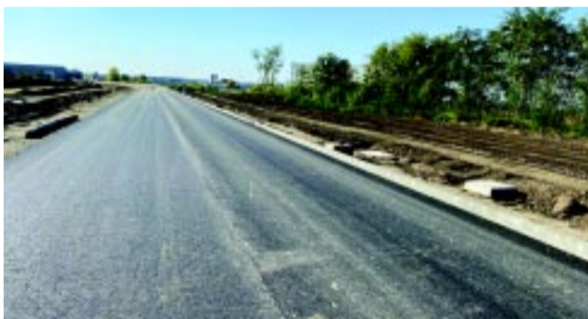
Kevésbé látványos, de fontos: az utépítés része a hírközlés és közvilágítás alépítmények építése is, itt például az 1. és 2. sz. körforgalom között
