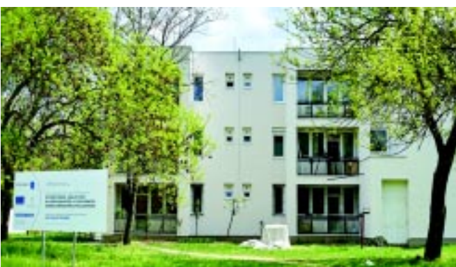
A Csaló közti nyugdíjsház felújítása is mutatja a szépkorúakra való odafigyelést a gyakorlatban
