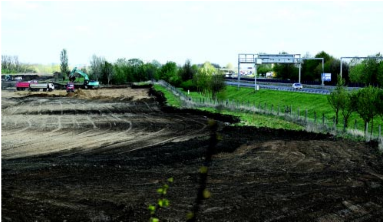
A Nyíregyházi Déli Ipari Park nagy volumenű fejlesztésének a közművek kiépítése is a részét képezi, köztük a szennyvízelvezetés
