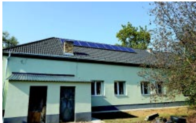
Az energetikai felújítások hosszú sora mérhető költség-megtakarítást hoz, valamint csökkenő hőveszteséget, környezetterhelést, például minden önkormányzati óvoda esetében
