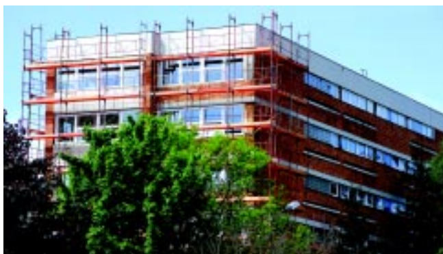
A Wesselényinél már látványos szakaszánál tart az energetikai célú felújítás
