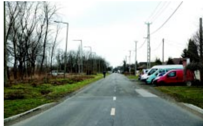
Megvalósul a Szélsőbokori út teljes körű felújítása is
