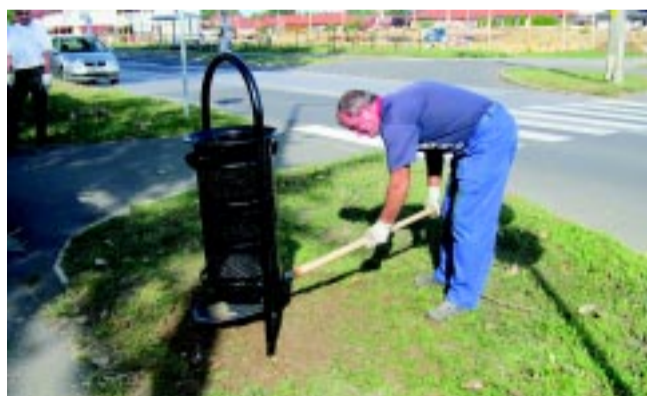
Örökösöldön a NYÍRVV Nonprofit Kft. 60 csőváz, vastagabb falú kosárral és merevítéssel készült hulladékos edényt helyez ki a régi, tönkrement szemetese helyett
