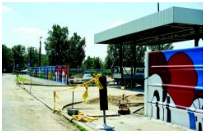
Az átépítés alatt lévő kapu a már festett kerítéssel
