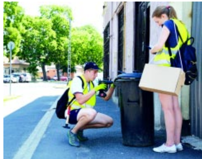
A rádiófrekvenciás chip elhelyezése egy gyűjtőedényen
