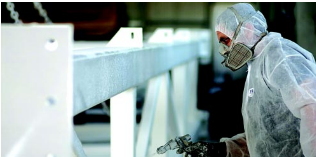
Védőréteget is kap a VMKK tetőszerkezete a Magyar Acélművek Kft.-nél szállítás előtt
