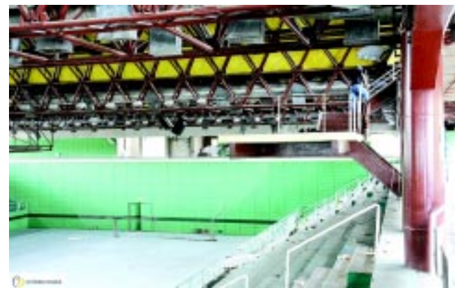
Az építési terület tavaszra modern csarnokbelsővé válik
