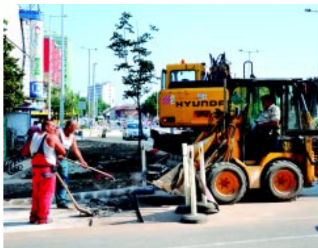
Befejezték a távhő gerincvezetékek cseréjét a Síp utcán
