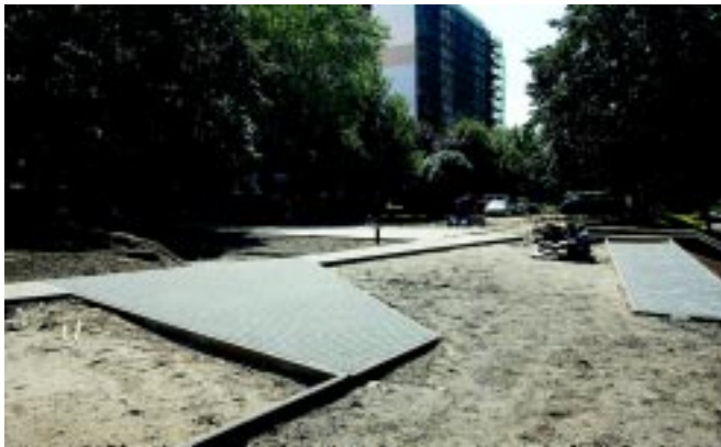
Végéhez közeledik a térrekonstrukció
