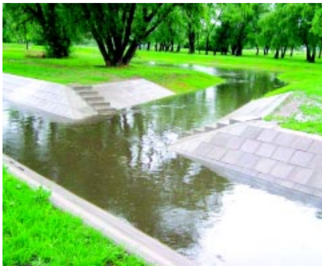
A földmedrű tározó munka közben, a Városi I-es csatorna alsó szakaszával, a záportározó belépő oldalánál
