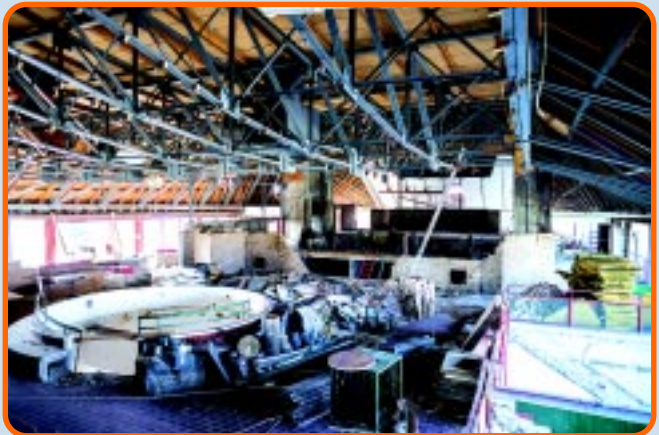
Az alig felismerhető belső tér bontás közben
